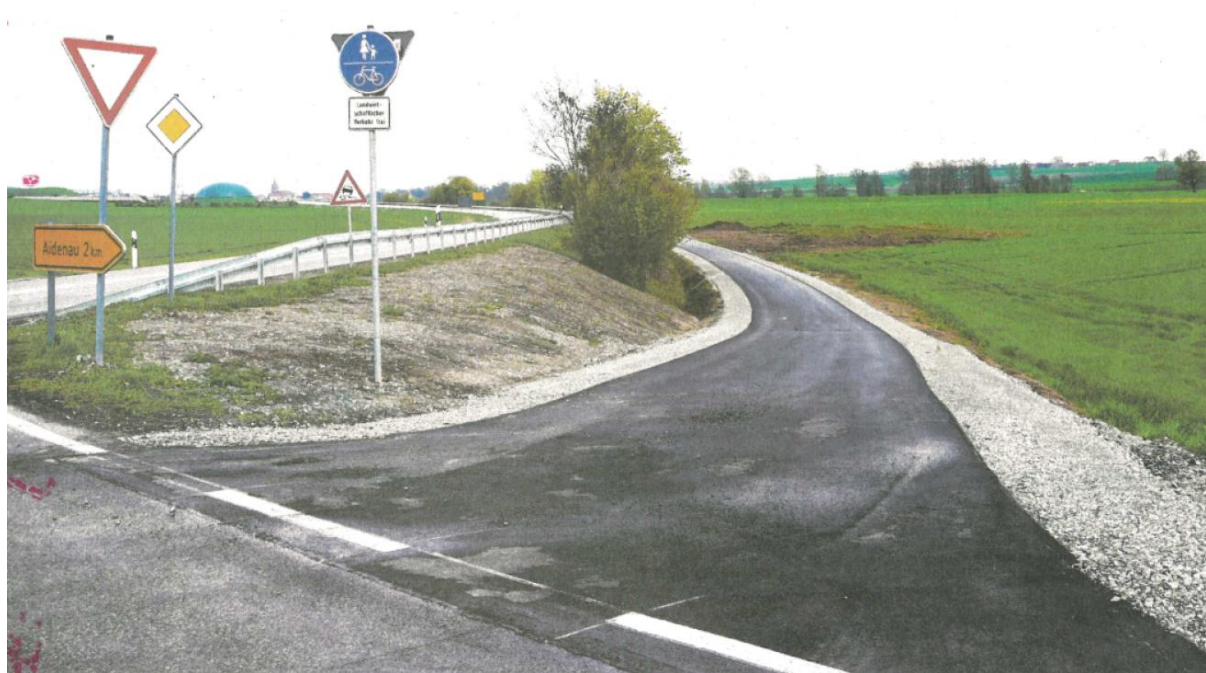
Seit heute kann ganz offiziell entspannt und sicher nach Geslau geradelt werden. Der Weg ist freigegeben.
