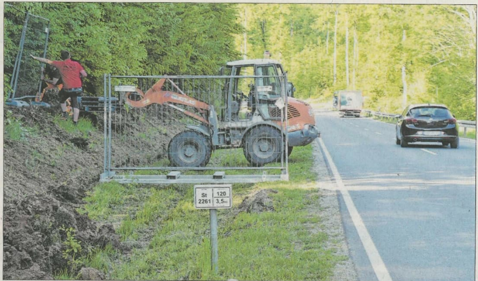
An der Staatsstraße 2261 zwischen Klosterdorf und der Elfseeleinsberg-Kreuzung haben die Bauarbeiten für einen neuen Rad- und Gehweg begonnen. Foto: Andreas Reum
