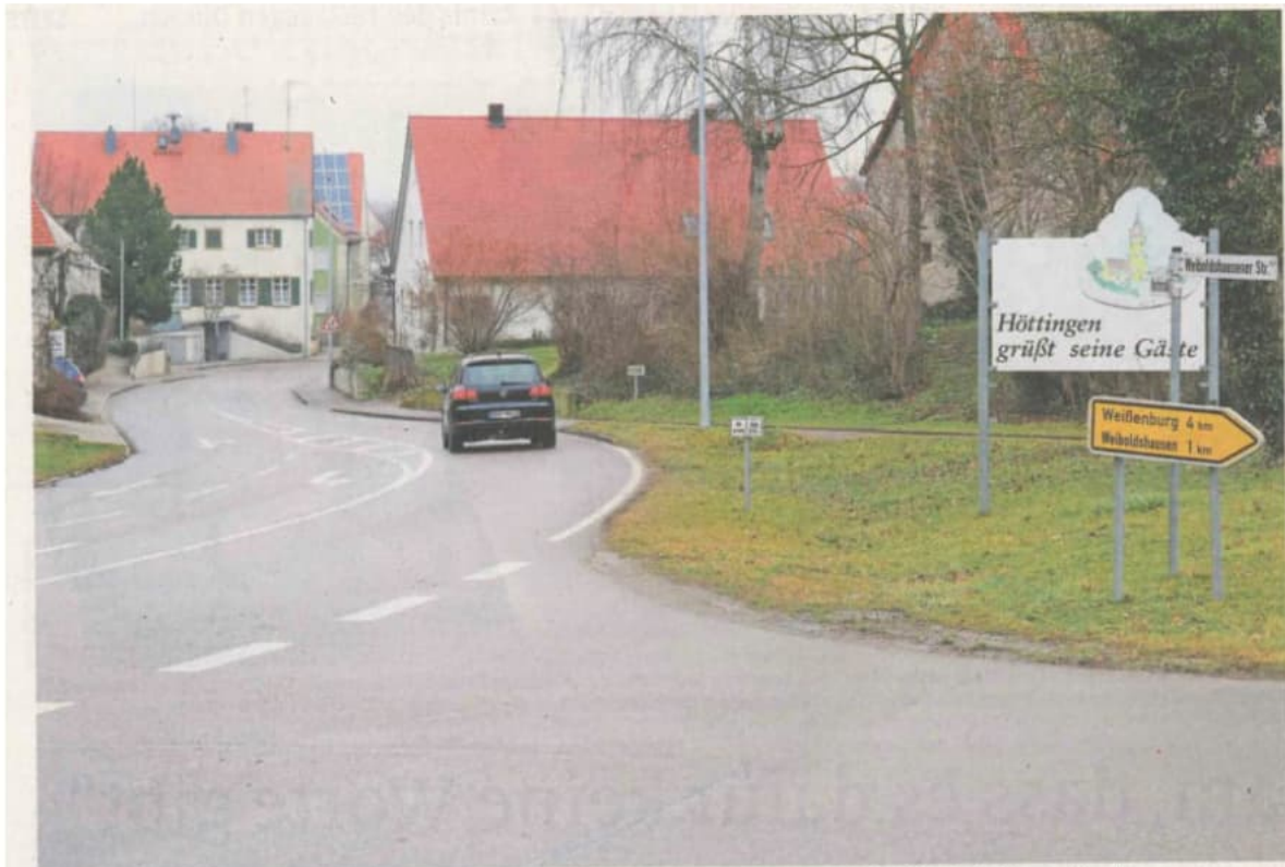
Die Staatsstraße durch Höttingen wird ab Mittwoch bis voraussichtlich Ende September komplett gesperrt. Grund ist die Straßen- und Kanalerneuerung.
