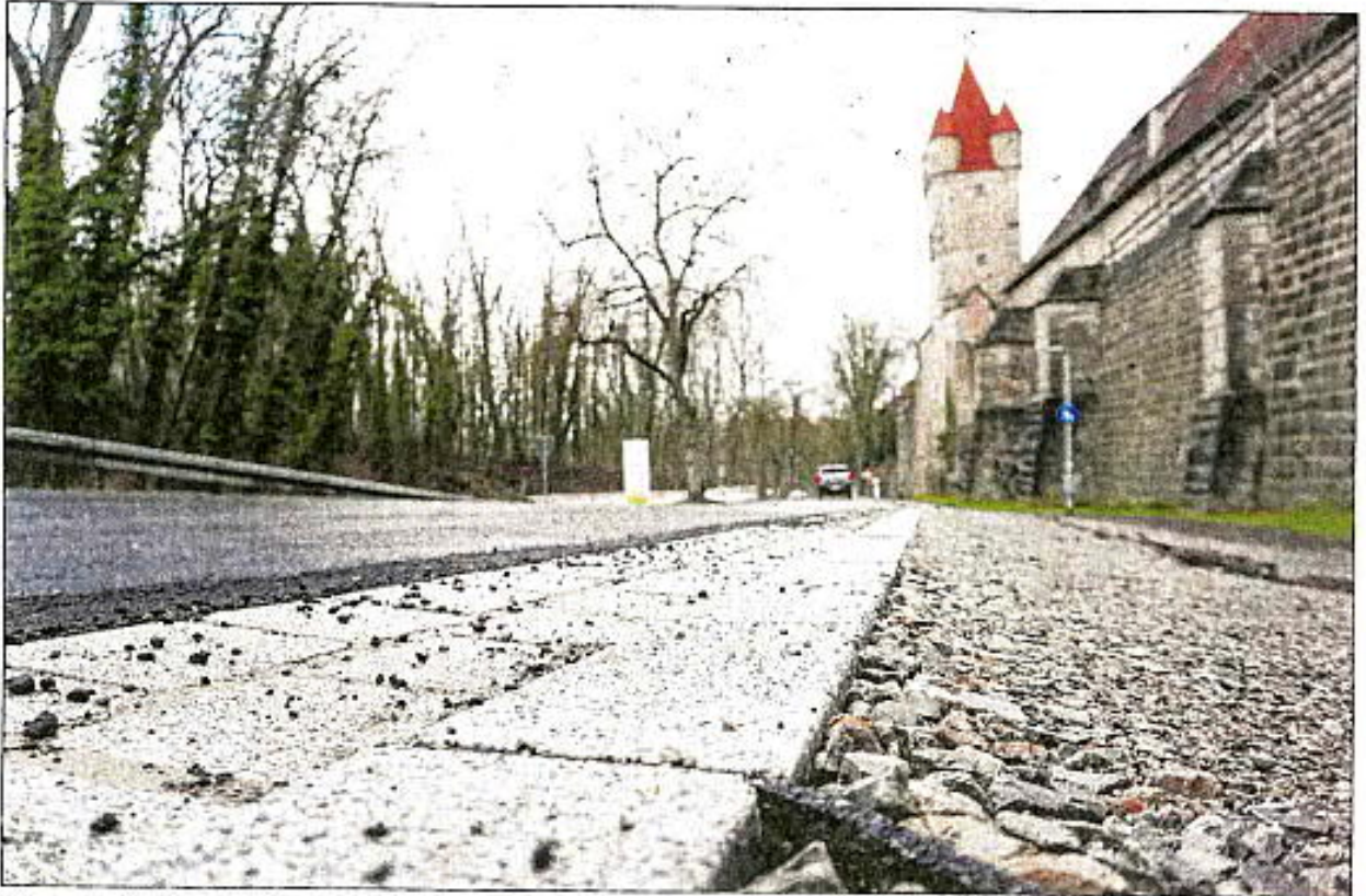
Die sanierte Staatsstraße 1022 zwischen Spitaltor und Stöberleinsturm (rechts). Allerdings wird in diesem Abschnitt noch eine Fahrbahndecke aufgetragen. Foto: Kai Schlichtermann
