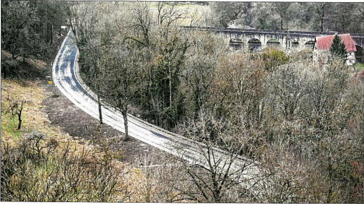
Der Blick von der Altstadt auf die frisch asphaltierte Staatsstraße 1022 im Taubertal in Richtung Schrozberg.
