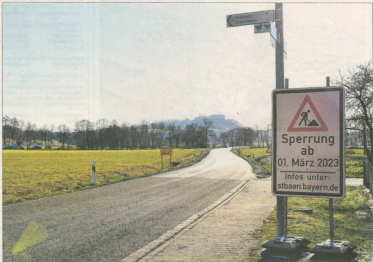
Ab morgen ist an dieser Stelle vorerst wieder Schluss für den öffentlichen Verkehr. Die Sanierung der Staatsstraße zwischen Bellershausen und Schillingsfürst geht in die zweite Runde. Mitte Mai sollen die Bauarbeiten voraussichtlich abgeschlossen sein. Foto: Simone Hedler
