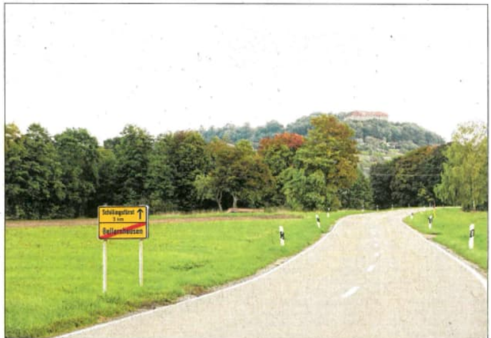
Risse, Spurrinnen und Verdrückungen weist die Staatsstraße 2247 auf. Deshalb wird sie nun saniert. Die Strecke von Bellershausen nach Schillingsfürst ist dann vollständig gesperrt. Foto: Larissa Haug
