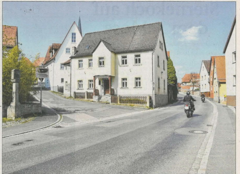
Die südliche Ortszufahrt von Oberscheinfeld, die Schlosstraße, soll noch im laufenden Jahr erneuert werden - nicht nur die Straße selbst, sondern vor allem auch die Gehsteige, wofür erhebliche Fördermittel in Aussicht stehen. Gleiches gilt für die davon abzweigende Pfarrgasse.
