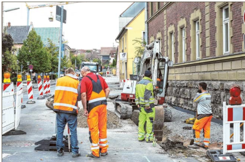
Die Arbeiten in der Ansbacher Straße verliefen laut der beauftragten Bau- firma bisher alles andere als optimal. Foto: Tizian Gerbing
