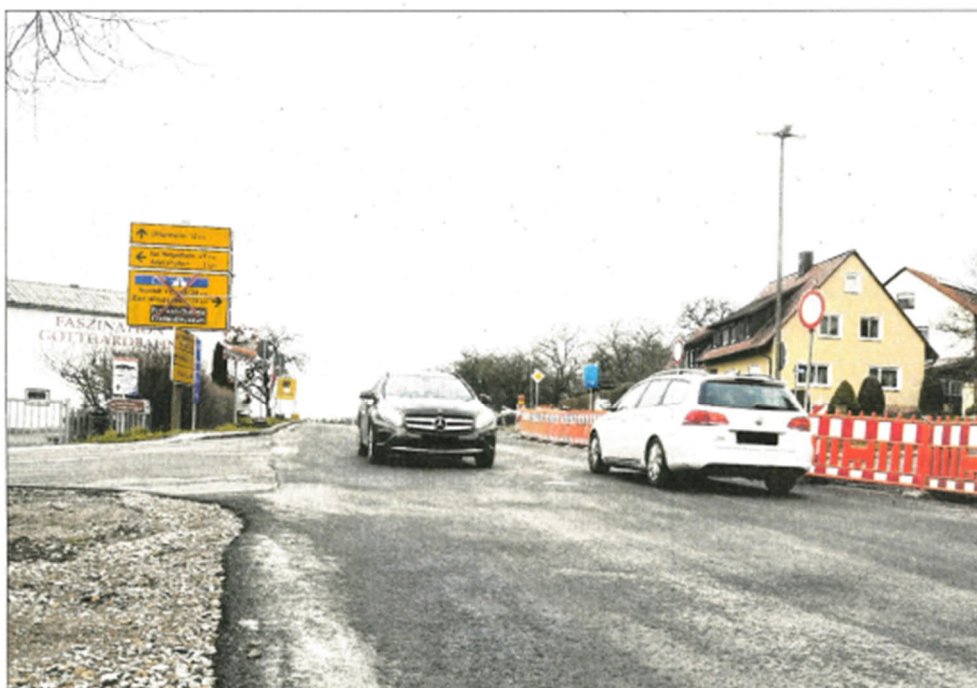
In Reichelshofen fließt seit einigen Tagen wieder der Verkehr: Zwar ist die Verbindung nach Endsee noch gesperrt und wird dies noch einige Wochen bleiben, doch zwischen Steinsfeld und Gumpelshofen können Autofahrer wieder problemlos und ohne Umwege fahren. Foto: Volker Raab
