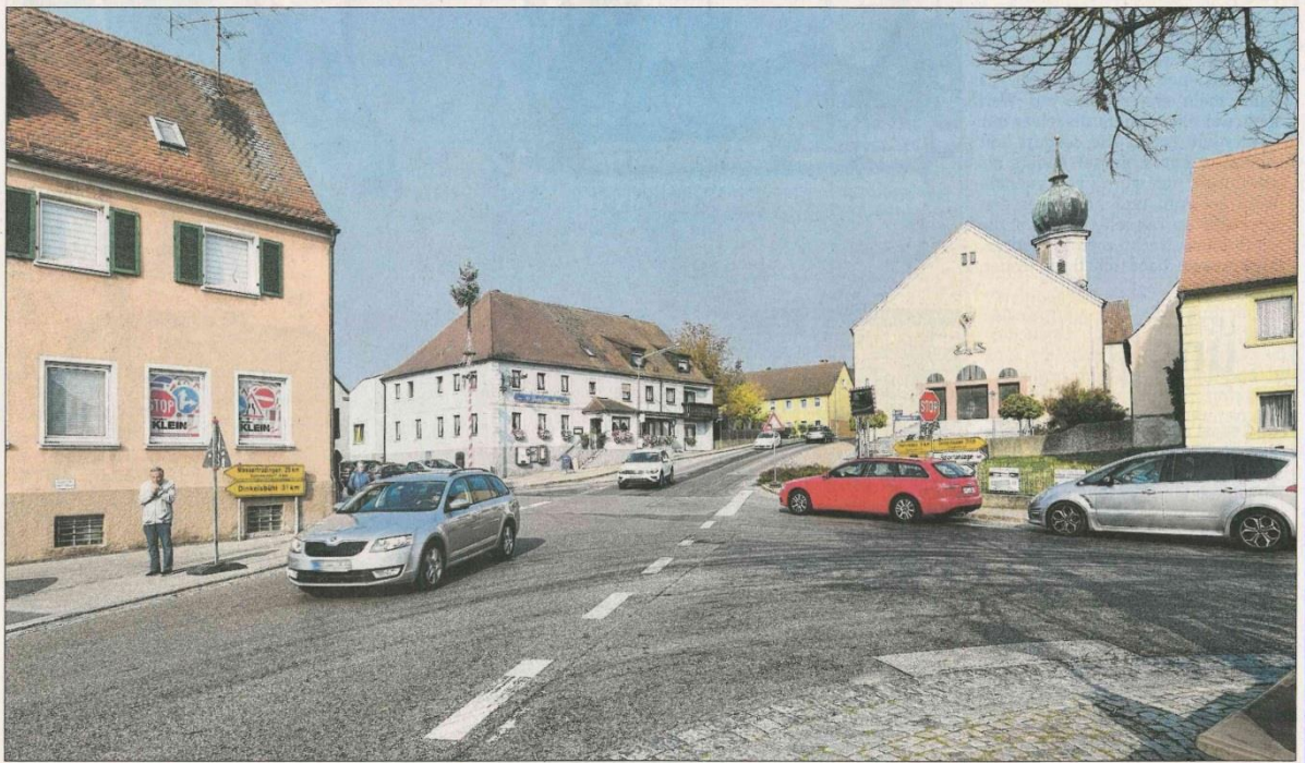
Viel Verkehr fließt über die Kreuzung in der Ortsmitte von Burgoberbach. Durch eine Neugestaltung soll die Situation dort insbesondere auch für Fußgänger angenehmer gestaltet werden. Um die Sicht zu verbessern, schlägt Bürgermeister Rammler vor, das Gebäude links zu kaufen und abzureißen. Foto: Jim Albright
