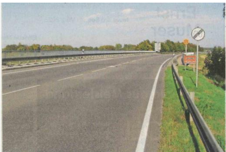
So sieht die Brücke über den Altmühlseeabfluss noch aus. Bald bestimmen Bauarbeiten das Bild inklusive einer Ampelanlage.
