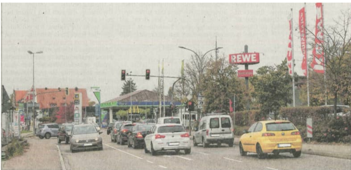
Die viel befahrene B25-Ortsdurchfahrt weist im Bereich der Brühl-Kreuzung Schäden in der Fahrbahndecke auf. Es haben sich dort laut Staatlichem Bauamt Spurrinnen und Verdrückungen gebildet. Foto: Markus Weinzierl
