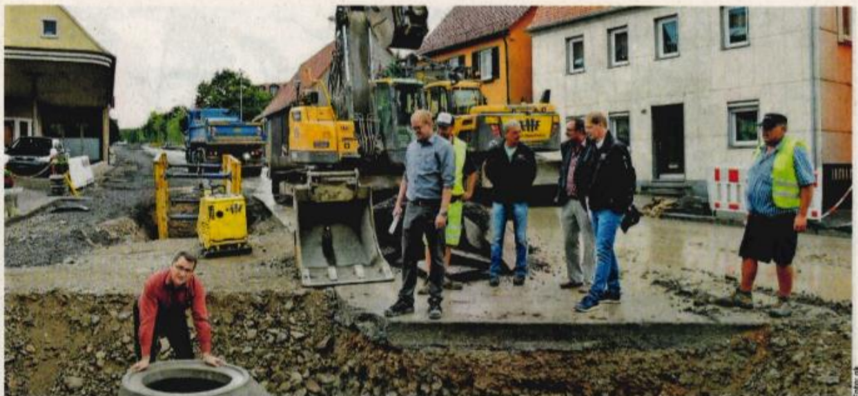
Ein Teilstück der Bundesstraße 13 in Uffenheim wird erneuert. Derzeit ist die Durchfahrt gesperrt, im September kann man zumindest Richtung Würzburg durchfahren. Vor Ort schauen sich Bürgermeister Wolfgang Lampe (links), Mitarbeiter der Verwaltung, des Planungsbüros und der Baufirma um. Foto: Gerhard Krämer
