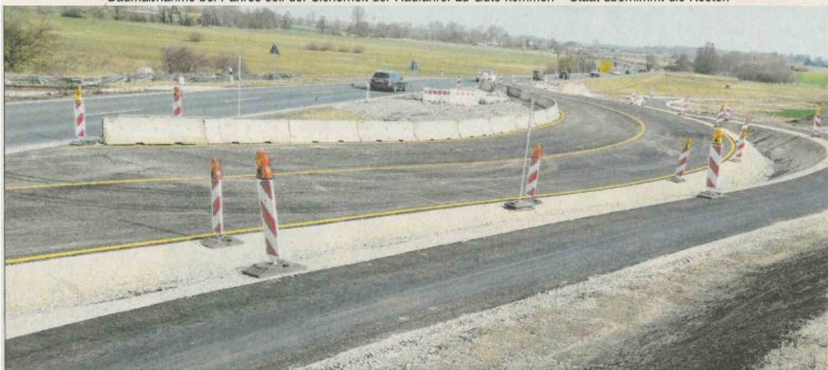
Die bereits errichtete Bedarfsumfahrung auf der B 470 zwischen der Abzweigung nach Pahres und der Abzweigung nach Rappoldshofen. Foto: Valentin Brendler
