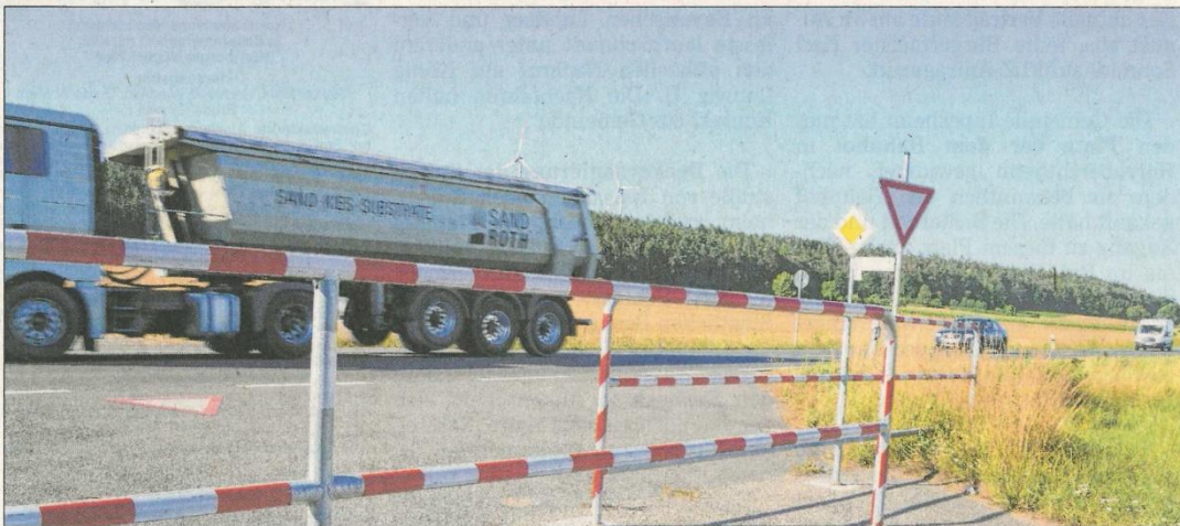
Nach den tödlichen Unfällen reagierte das Landratsamt schnell und ließ zur Sicherheit der Radfahrer als Übergangslösung eine Umlaufsperrung aufstellen und Vorfahrt-achten-Markierungen auf dem Boden anbringen. Foto: J. Zimmermann
