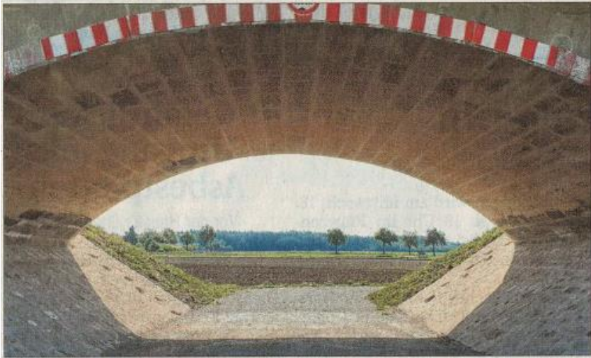
Ideale Unterführung – doch sie endet im Acker: Zwischen dieser Bahnbrücke und Hannenbach bekommt das Staatliche Bauamt keine Flächen.
