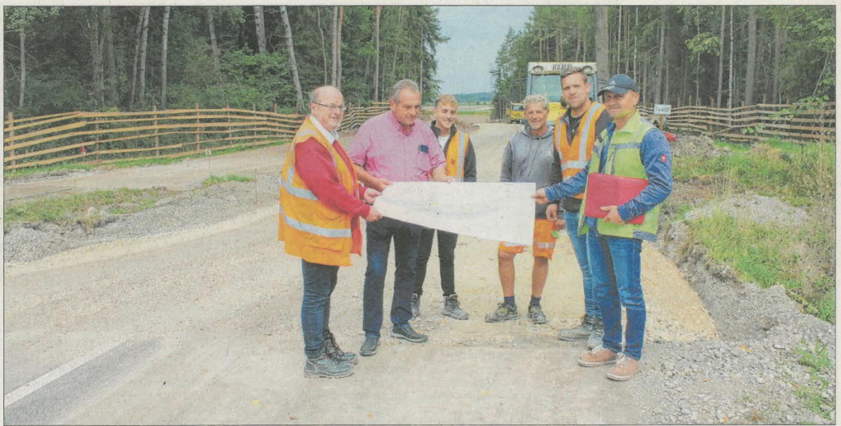
Informierten über den Stand der Ausbaurbeiten an der Staatsstraße 2248 (von links): Andreas Fächner vom Staatlichen Bauamt, Wieseths Bürgermeister Walter Kollmar, Josef Hompf vom Planungsbüro sowie Martin Brenner, Dominic Müller und Reiner Riedel von der ausführenden Firma. Foto: Herbert Dinkel
