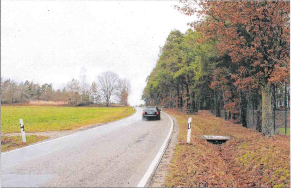
Der Ausbau der Staatsstraße 2248 zwischen Wieseth und Häuslingen soll, wie es in der jüngsten Gemeinderatssitzung hieß, im Frühjahr in Angriff genommen werden. Dabei wird auch die unübersichtliche Kuppe (Bild) auf Höhe der Einfahrt zum künftigen Gewerbegebiet abgesenkt.
