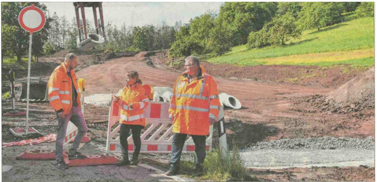
Frank Biedermann vom Staatlichen Bauamt in Ansbach (links), Bauleiter Erwin Pfeiffer und Neuhofs Bürgermeisterin Claudia Wust trafen sich an der Baustelle. Mit der Baumaßnahme wird die Staatsstraße zwischen Oberfeldbrecht und Neuhof auf der Achse Ansbach–Neustadt ausgebaut. Foto: Ute Niephaus
