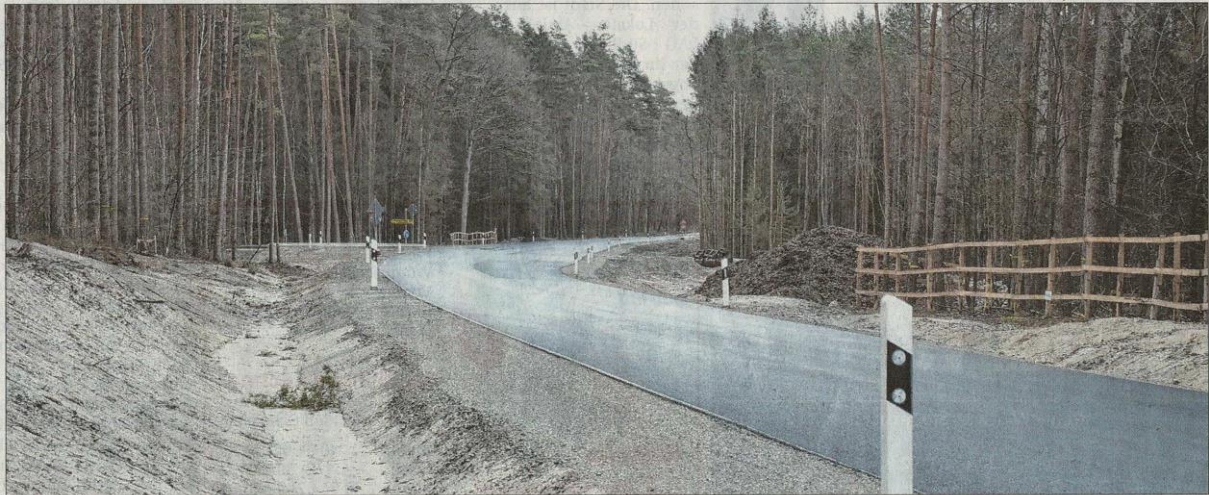
Zur Entschärfung eines Unfallschwerpunktes wird die Staatsstraße ab Linden noch einmal für knapp sechs Wochen gesperrt.
