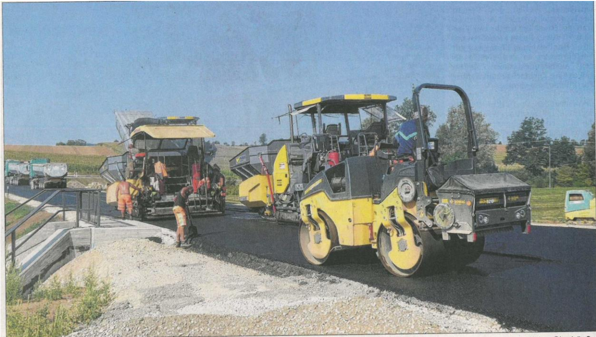
Unter großem Maschineneinsatz werden die restlichen Asphaltierungsarbeiten ausgeführt.
