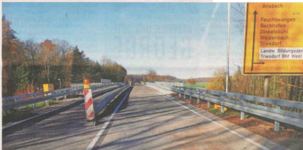
Ende November werden die Sanierungsarbeiten an der Bahnbrücke bei Willendorf weitgehend abgeschlossen sein, der Verkehr kann dann auf der B13 wieder ungehindert fließen.
