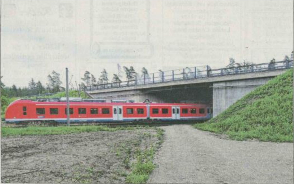
Von der 1938 gebauten Brücke, die die Bundesstraße 14 über die Bahnlinie führt, ist nichts mehr zu sehen. Das Bauwerk wurde abgerissen und durch einen Neubau ersetzt.
