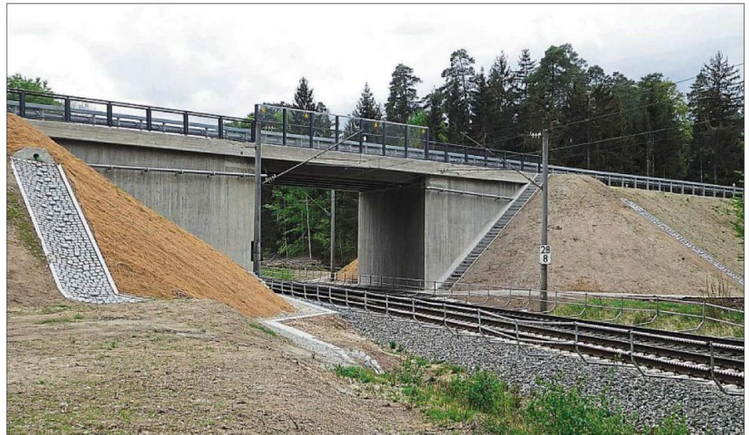
Die neue Brücke im fertigen Zustand.
