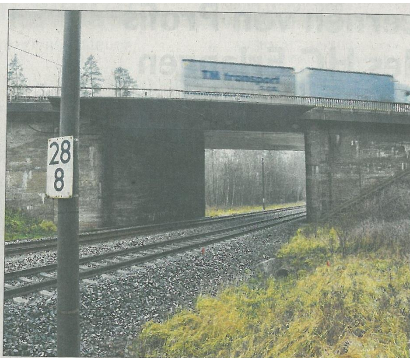
Die Brücke über die Bahnstrecke Ansbach-Nürnberg wird im Jahr 2019 durch einen Neubau ersetzt. Während der Bauzeit können die Fahrzeuge auf der B 14 auf einer Behelfsbrücke die Gleise überqueren. Foto: Albright
