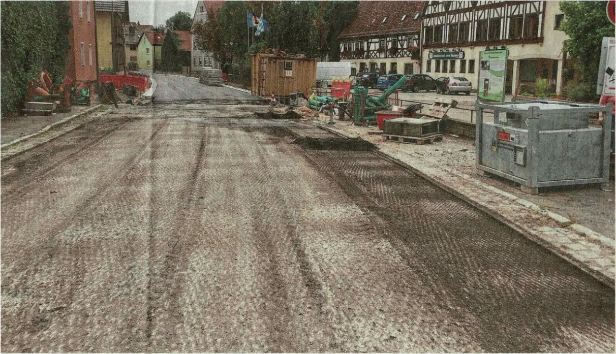
Mittlerweile hat der zweite Bauabschnitt bei der Erneuerung der Ortsdurchfahrt in Oberickelsheim begonnen. Jetzt wird vom Gasthaus in der Ortsmitte bis zum Ortsende Richtung Ochsenfurt gebaut.
