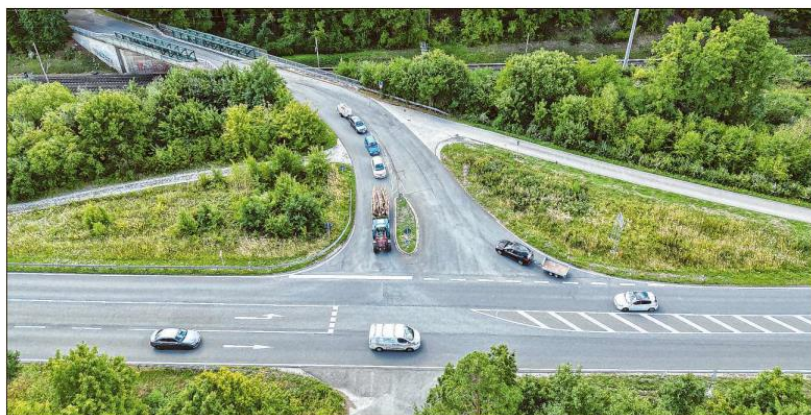
Für den Umbau der Anschlussstelle West–Wulkersdorfer Brücke bei Emskirchen wurde die aktuelle Planung vorgestellt. Foto: Mirko Fryska
