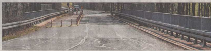
Die Wulkersdorfer Brücke auf der Höhe von Emskirchen-West soll nun mit einer Stahlkonstruktion ertüchtigt werden. Die Befahrbarkeit der Brücke soll auf diese Weise erhalten bleiben, bis ein Ersatzbau kommt. Fotos: Ute Niephaus
