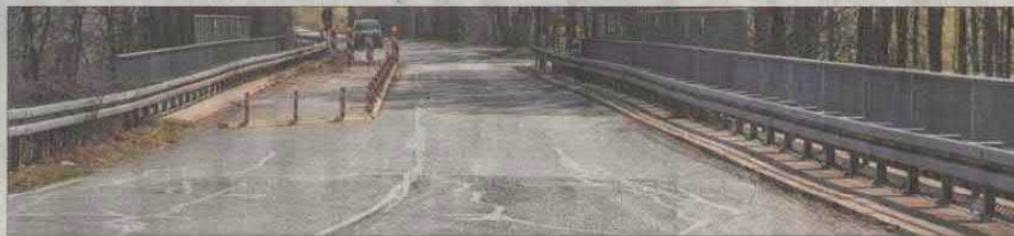
Die Wulkersdorfer Brücke auf der Höhe von Emskirchen-West soll nun mit einer Stahlkonstruktion ertüchtigt werden. Die Befahrbarkeit der Brücke soll auf diese Weise erhalten bleiben, bis ein Ersatzbau kommt. Fotos: Ute Niephaus
