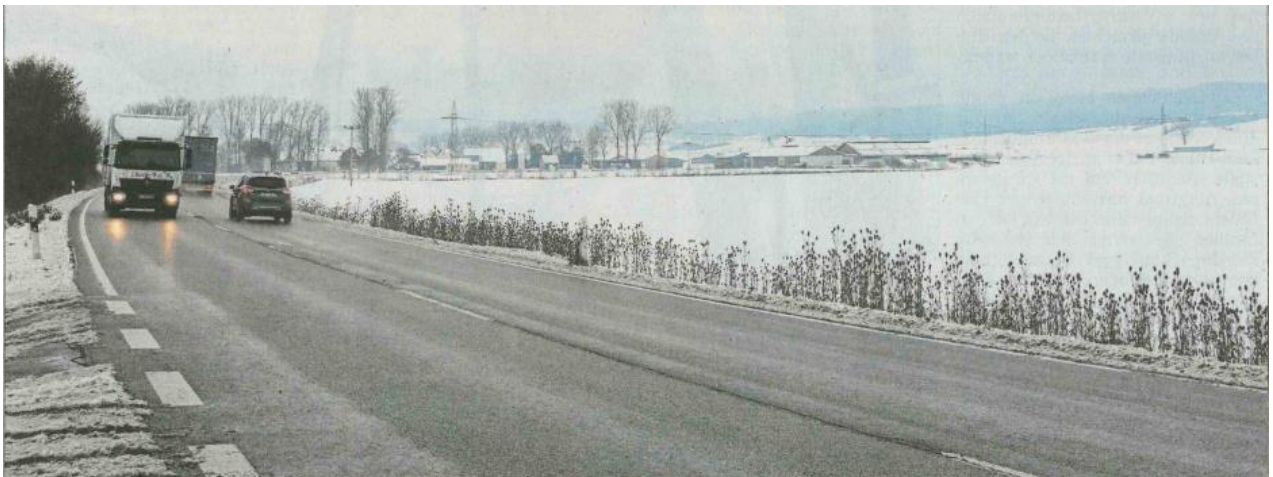
Zwischen dem Kreisverkehr östlich von Bad Windsheim und Lenkersheim (im Hintergrund) soll die Umgehungsstraße von der bestehenden Trasse in Richtung Süden (im Foto rechterhand) abzweigen. Foto: Claudia Lehner
