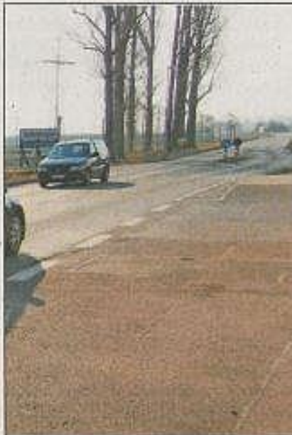
Hier soll auch künftig der Verkehr nach Lenkersheim rollen. Foto: Bastian Lauer
