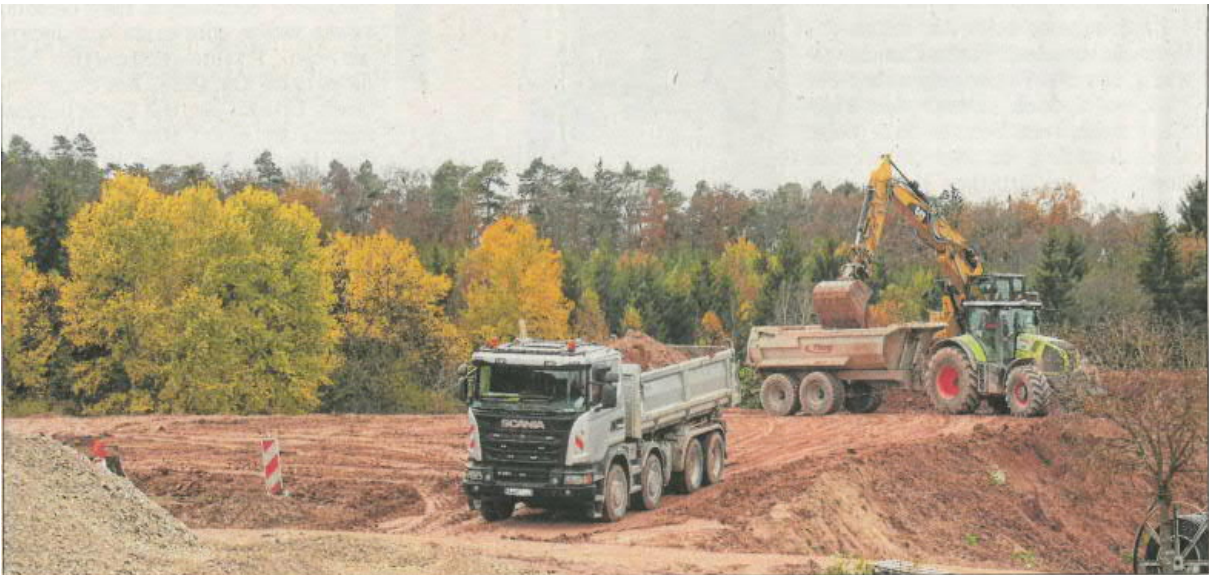
„Lieferverkehr“ im Baustellenbereich: Lastwagen und Traktorgespanne sorgen für einen reibungslosen Transport der Erdmassen.
