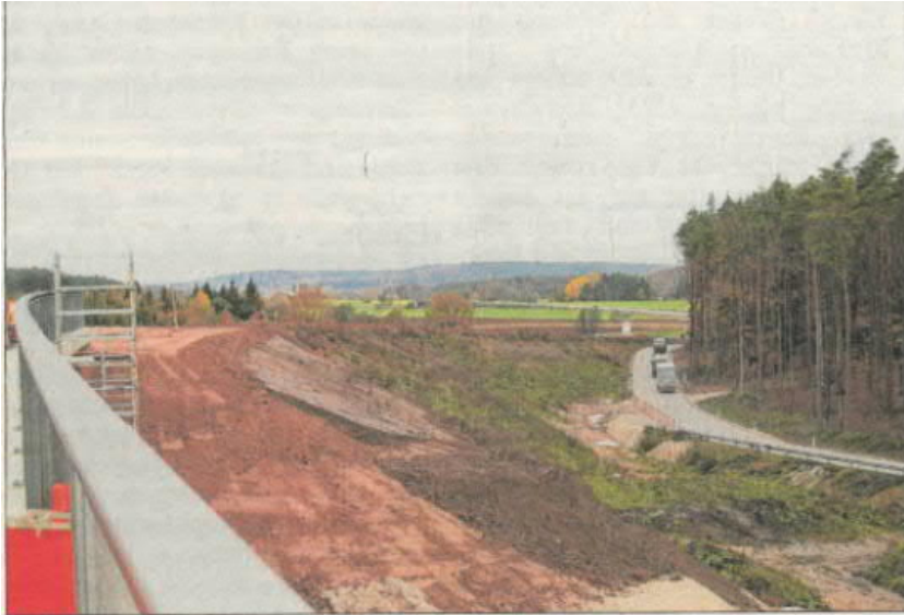
Auf der alten Trasse der Bundesstraße (rechts im Bild) rollt der Verkehr an der Baustelle vorbei.
