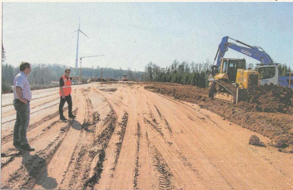
Bauleiter Markus Nölp (mit Warnweste) erläuterte dem Leiter des Staatlichen Bauamtes, Heinrich Schmidt, den Fortschritt der Straßenbauarbeiten bei Greiselbach. Foto: Markus Weinzierl
