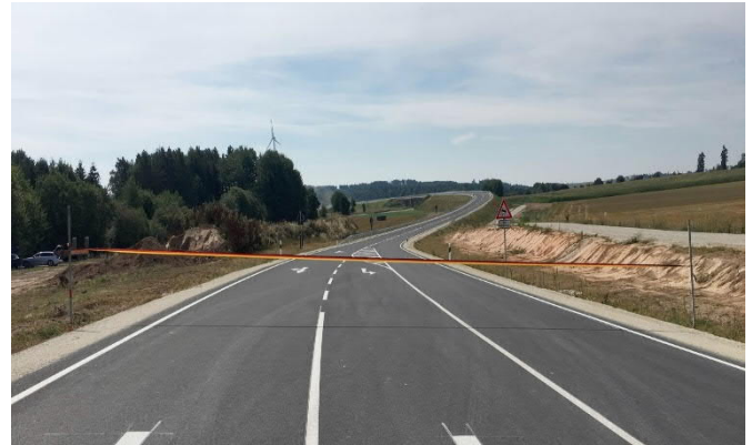
Eröffnung BA 1 06.08.2019, Blick Richtung Süden
