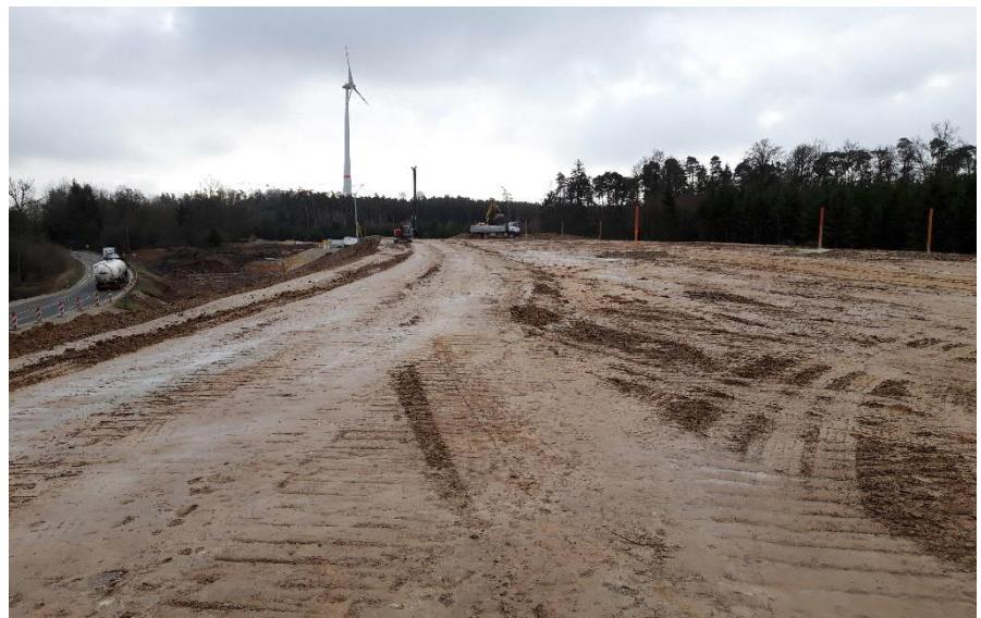
Bauabschnitt II 10.Dezember 2019, Blick Richtung Süden auf Bahnbrücke
