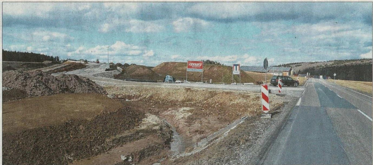
Noch liegen Schotter- und Erdhaufen an der Trasse der künftigen Ortsumfahrung von Greiselbach. Bis Mitte des Jahres soll der Verkehr auf der neuen Straße rollen. Ein genauer Zeitplan wird demnächst vorgestellt. Foto: Tippel
