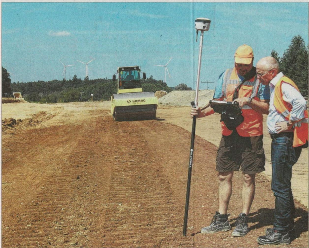
Moderne Messtechnik im Einsatz: Harald Rühl und Andreas Buchner vom Staatlichen Bauamt (von links) kontrollieren auf der Trasse der Umfahrung die Höhe des Planums. Die Planunterlagen sind digital erfasst und Koordinaten zugeordnet. Damit ist jeder Punkt auf der Baustelle per GPS hinsichtlich seiner Übereinstimmung mit der Planung überprüfbar. Foto: Weinzierl
