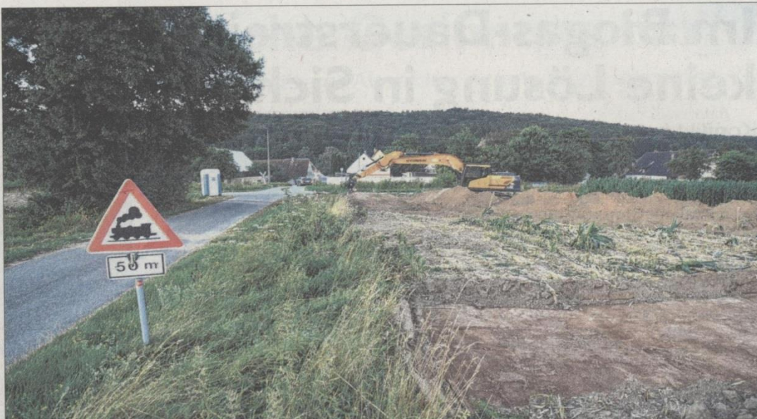
Der erste Bagger ist bereits an einem Trassenstück der künftigen Ortsumfahrung von Greiselbach mit Schürfgruben beschäftigt. Foto: Tippel
