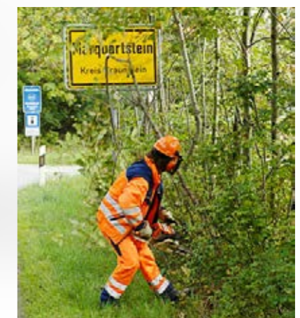
Verkehrszeichen müssen regelmäßig freigeschnitten werden, um die Verkehrssicherheit zu erhalten.
