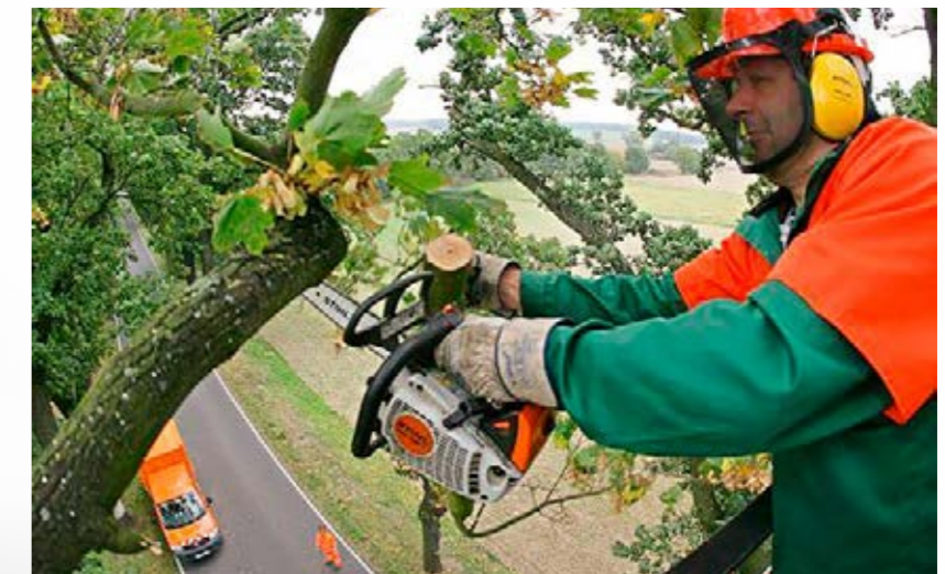
Alleebäume werden beschnitten: Auf einer Hebebühne hoch über einer Allee wird von einem qualifizierten Straßenwärter ein morscher Ast von einer Eiche entfernt.
